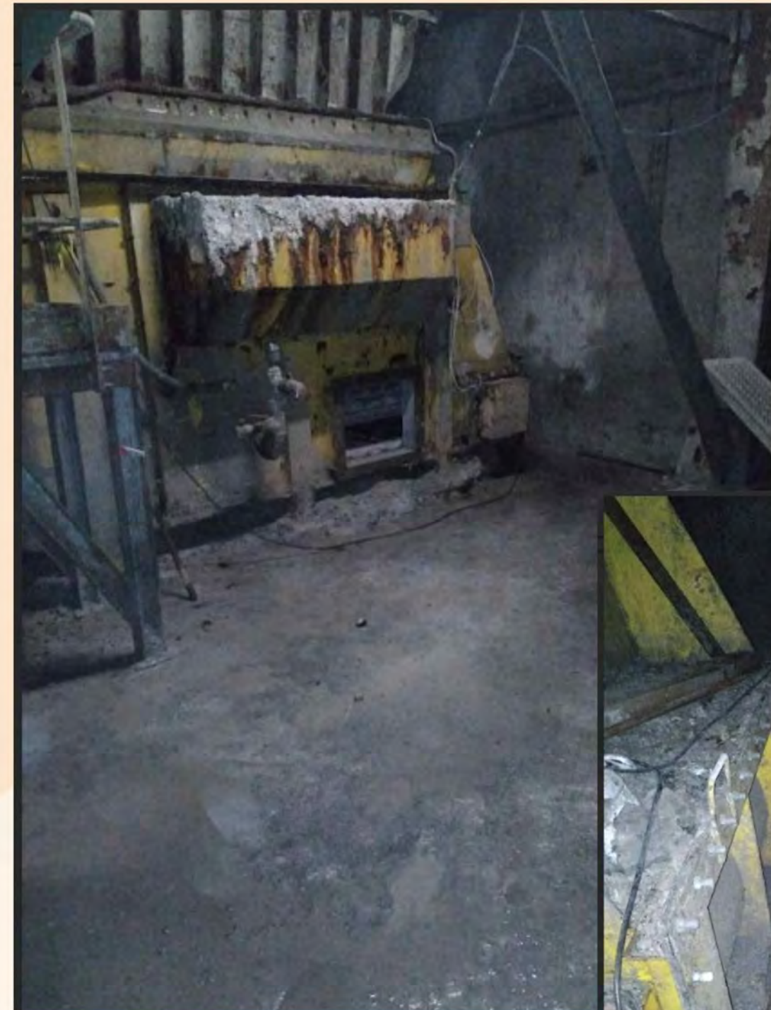
Nettoyage zone Mayfran
